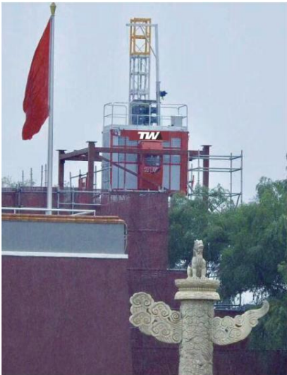
20米无附着（天安门修缮工程） 20 meters without attachment.
