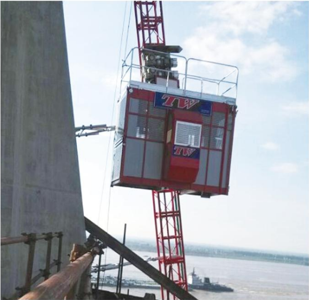
倾斜式施工升降机（最大倾斜度15°）
